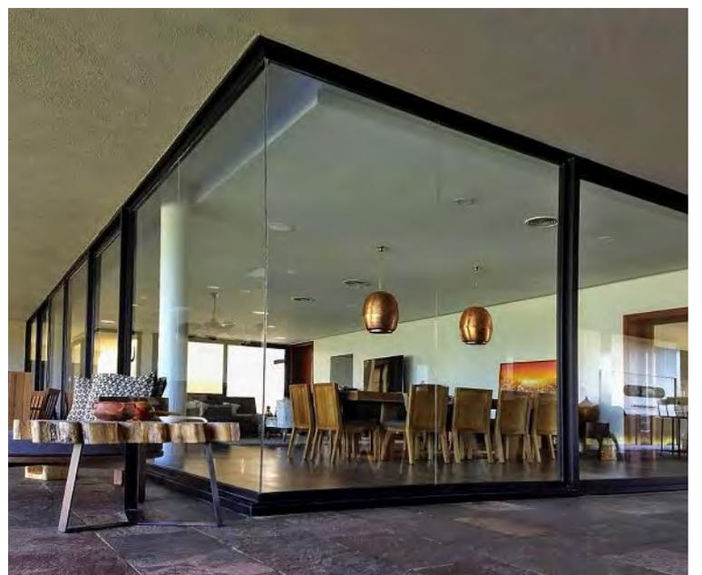
El diseño de sus perfiles lo convierte en el sistema de alta prestación ideal para aberturas de gran tamaño y resistencia a la carga del viento. Su exclusivo mecanismo alzante para puertas y ventanas corredizas otorga mayor hermeticidad a la abertura, gracias al cierre hermético con burletes y a la posibilidad de agregar puntos de cierre.
