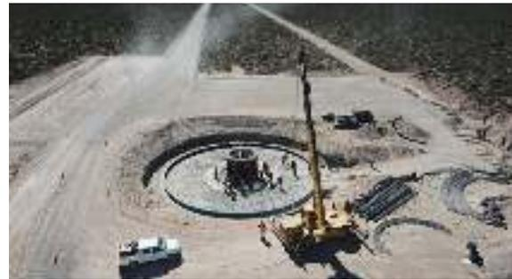
> Figura 8. Conformación de las bases de los aerogeneradores (jaula de pernos).
