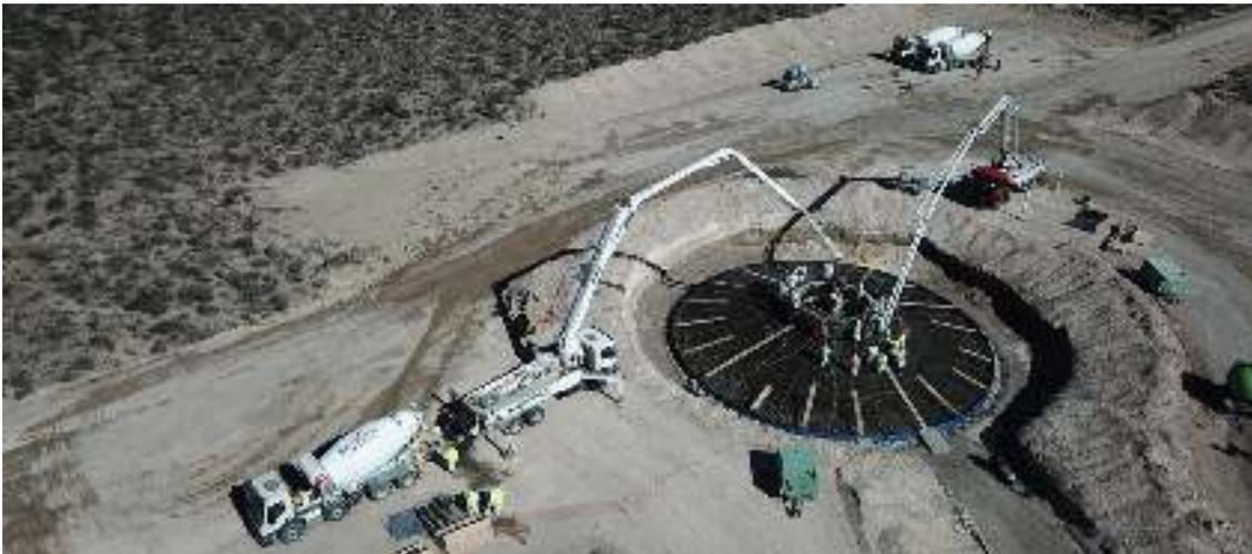
> Figura 9. Conformación de las bases de los aerogeneradores (armadura metálica).
